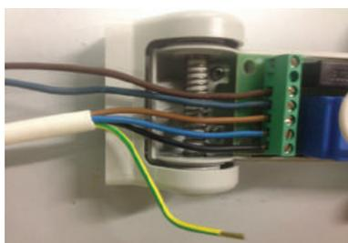
Collegare i cavi del motore alla centralina integrata nel sensore.
